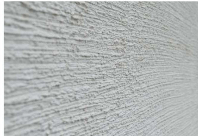
Fasáda 1.NP Hrubá omítka s výraznější strukturou, například lineárním svislým směrem, šedobéžová barva.
