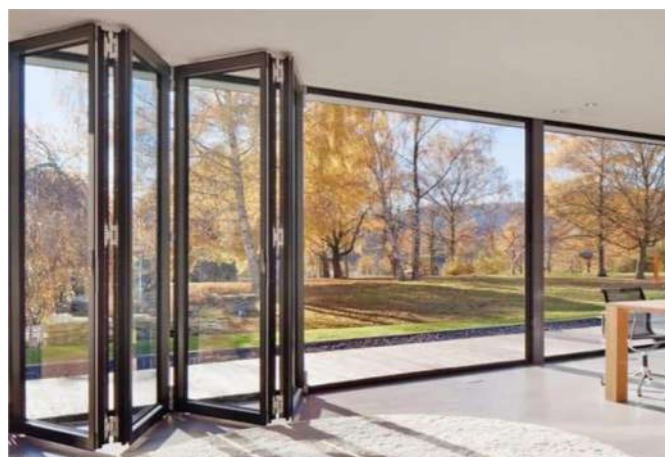
Dveře směrem k rybníku Hliníkové harmonikové dveře umožňují maximální světlost otevřených dveří. Navrženo v barvě šablon.
