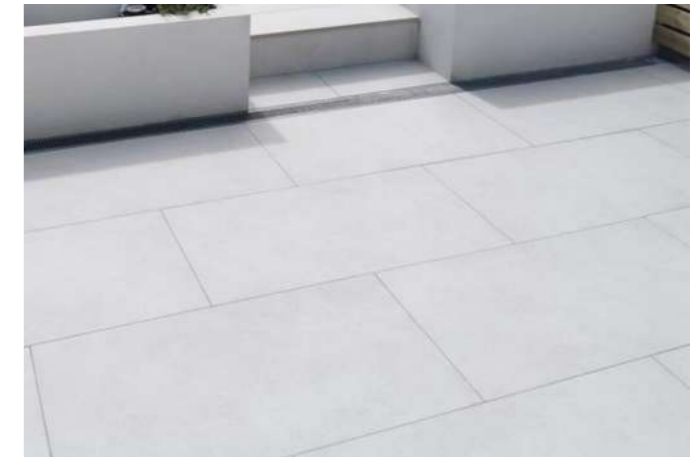
Dlažba před vstupem Velkoformátová betonová dlažba vymezující předprostor, včetně schodů a ramp vedoucích do KC.
