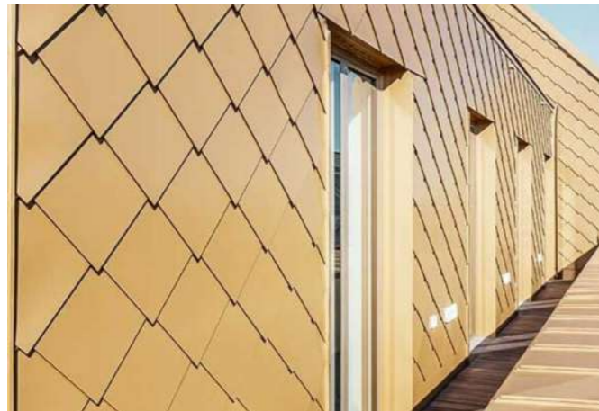
Střecha, fasáda 2.NP Falcované šablony, světle hnědá barva, velikost šablony 44x44, včetně detailů oplechování, apod.
