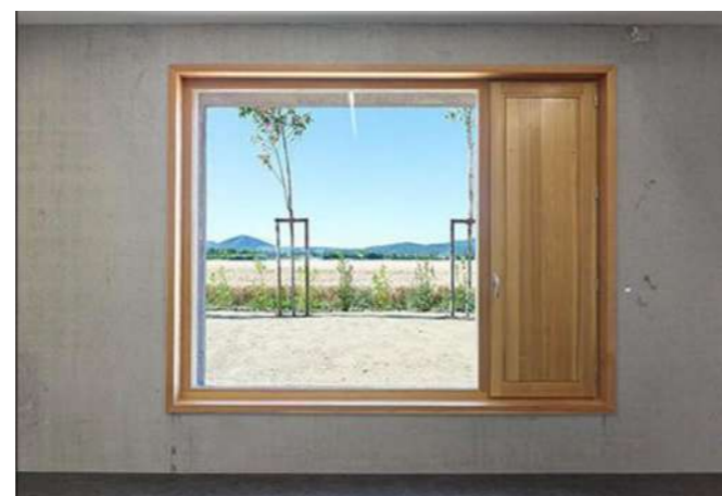
Okenní otvory Dřevěné rámy s fixními skly a dřevěnými, plnými větracími křídly. Mají Šambrány a sedací parapety.
