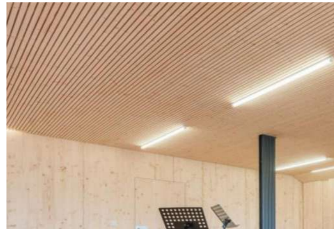
Podhled Dřevěné panely optimalizující akustické vlastnosti sálu a knihovny. Profily jsou frézované perforované.
